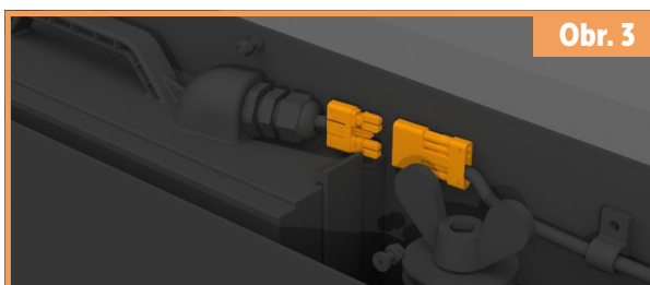
Konektor připojení baterie k řídicí jednotce.
